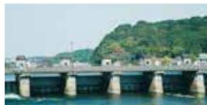
1905年に建設され、現在の洗堰は1961年に完成した二代目。明治期に建造された初代の洗堰「南郷洗堰」は、少し上流の両岸にレンガの堰柱が記念として残されている。
