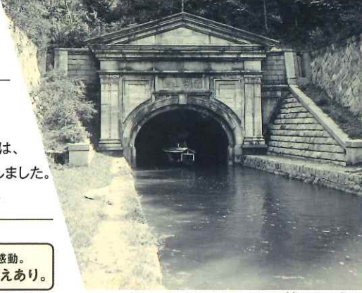
第三トンネル
