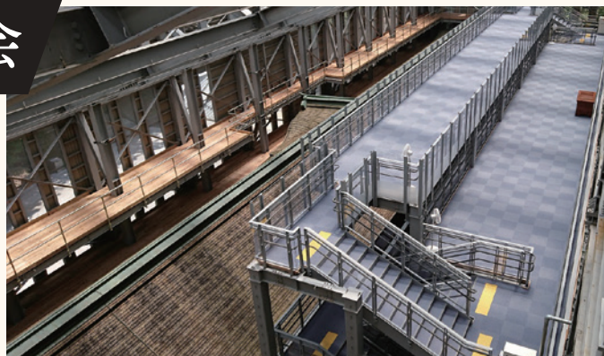
根本中堂改修工事現場(イメージ)
